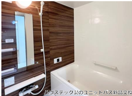
爪ハウステック製のユニットバス新品交換
